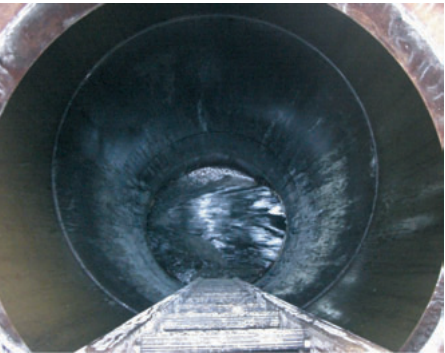
通過マンホール
