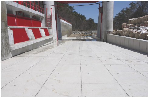
耐衝撃・耐摩耗に対する補強 (頭首工排砂ゲート)
