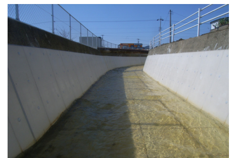
粗度係数の改善・耐久性向上 (農業用水路開渠)
