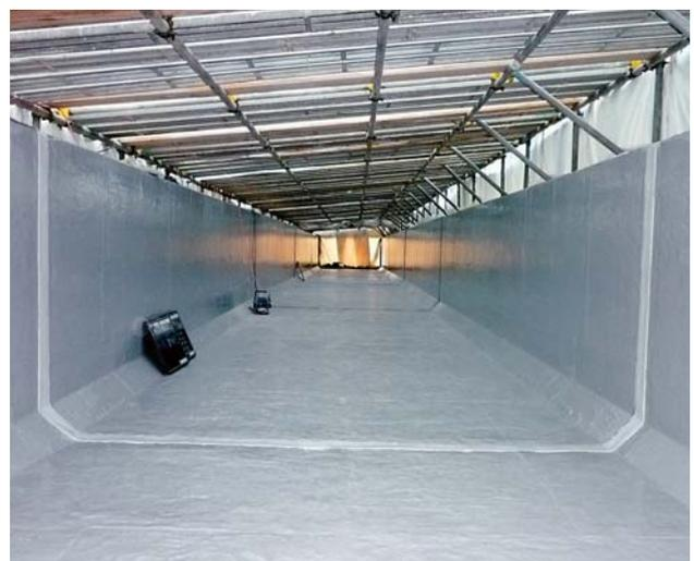
水路目地補修 (HSPU 目地工法)
